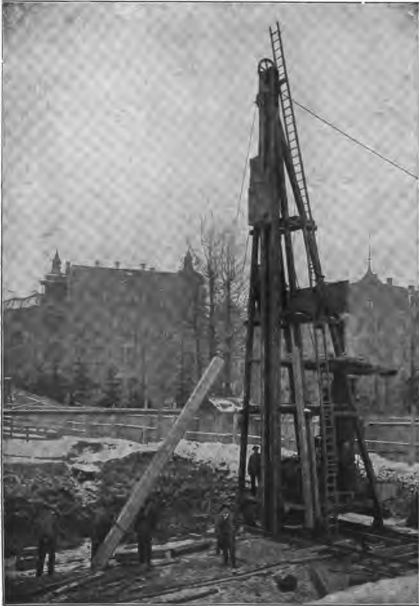
FIG. 268.—Station in Cannstatt. Hoisting piles.
