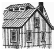
Una casa de hierro galvanizado
